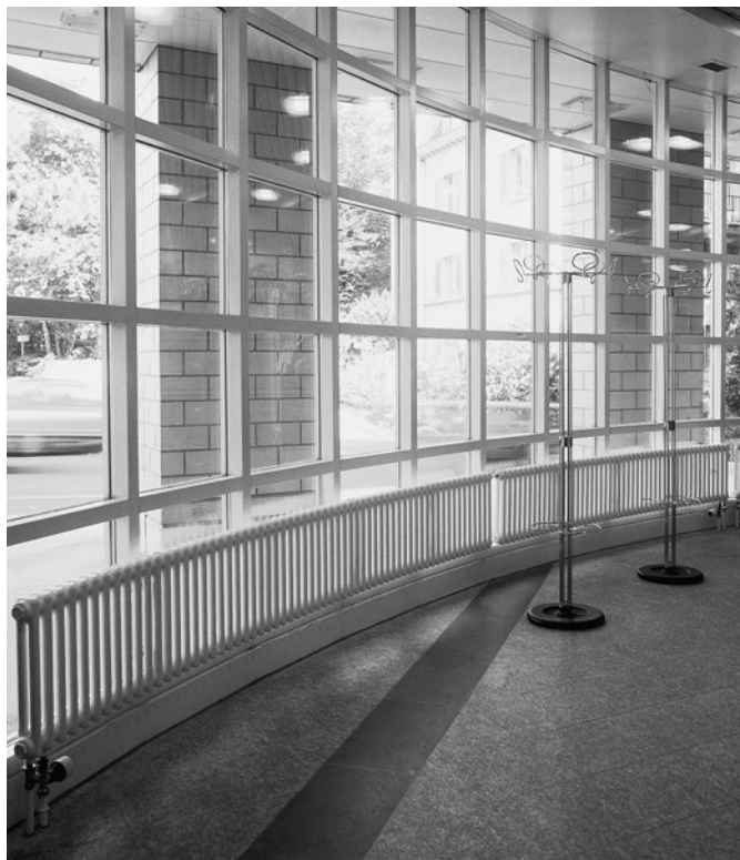
Esecuzione ad arco davanti a superficie finestrata
