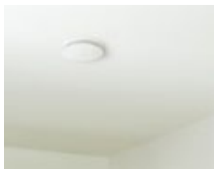
Montage au plafond
