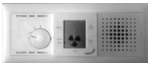
Zehnder ComfoSense in una combinazione Feller EDIZIOdue
